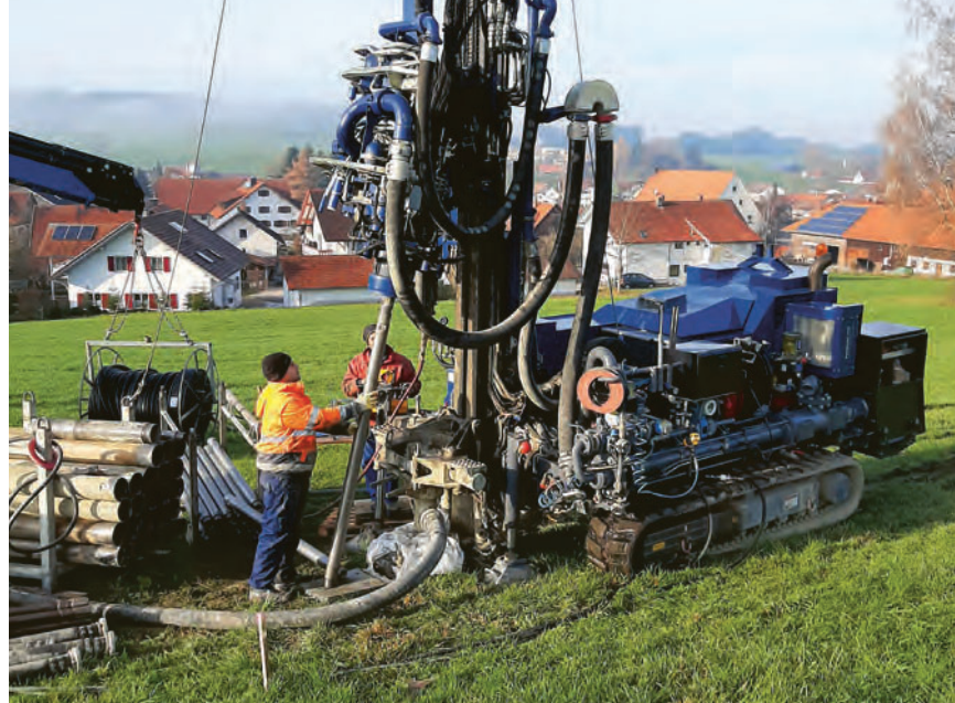
Mustergültig Sein eigenes Haus baute Kurt Zügner energieneutral
