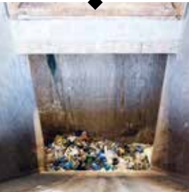
Hungriger Schlund Über Rutschen gelangt der angelieferte Müll in den Bunker
