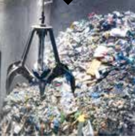
Müllberg abtragen Per Kran werden zehn Tonnen Müll pro Stunde in den Mülofen geworfen
