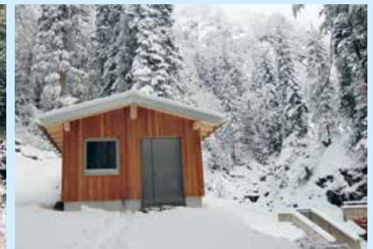
Turbine im Anflug Das Herzstück des Kraftwerks Gernbach wird eingeflogen (l.). Ein Häuschen schützt die Anlage
