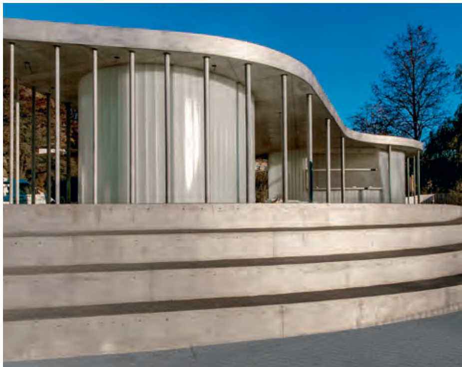
Neben der Staustufe liegen ab sofort die neuen Verweilstufen der Stadt
