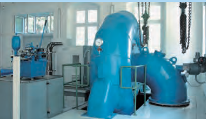
Modernes Herzstück: Die bestehende Francis-Turbine wurde im Jahr 2000 zu einer Diagonalturbine umgebaut
