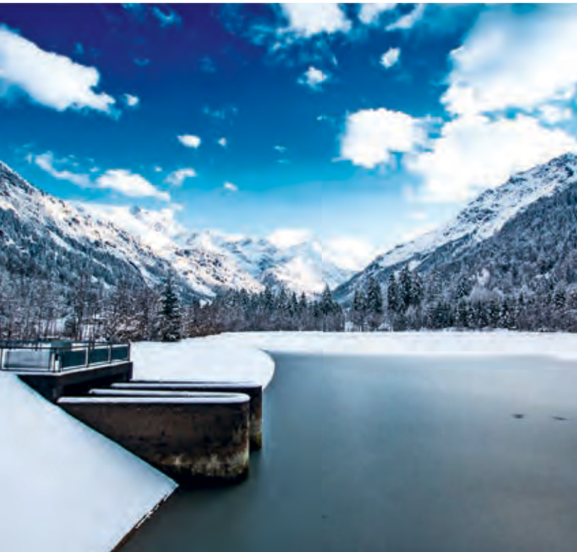
Sammelbecken: Im Unterbecken wird das Wasser nach der Energieerzeugung gestaut, bevor es gleichmäßig in die Stillach abgegeben wird
